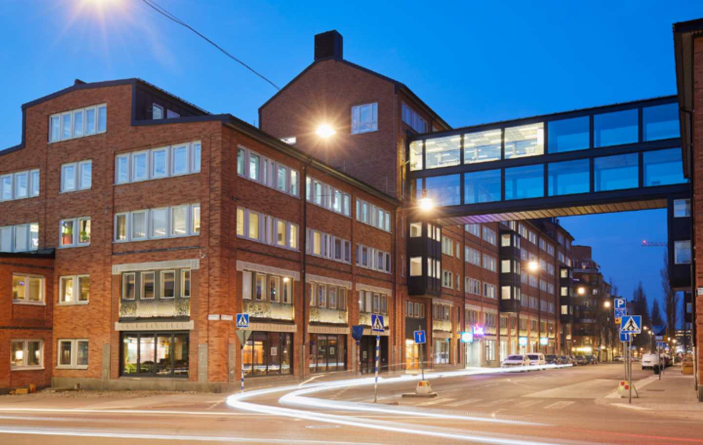
Stockholmsverken håller på att omvandlas till en modern mötesplats på Söder.
